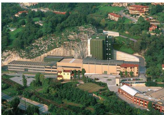
Stabilimento di Sala al Barro (LC)
