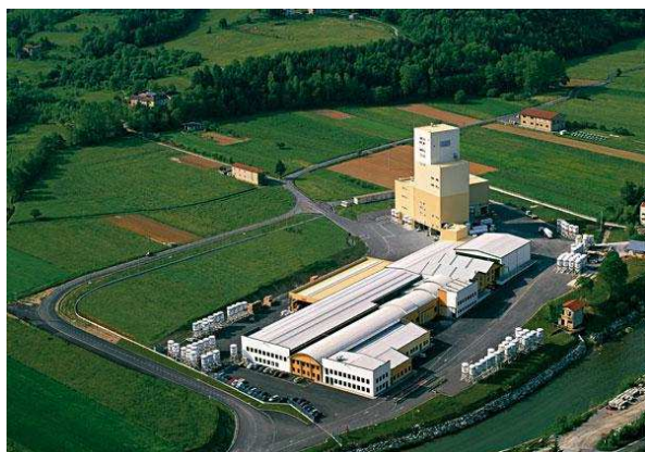
Stabilimento di Bagnasco (CN)
