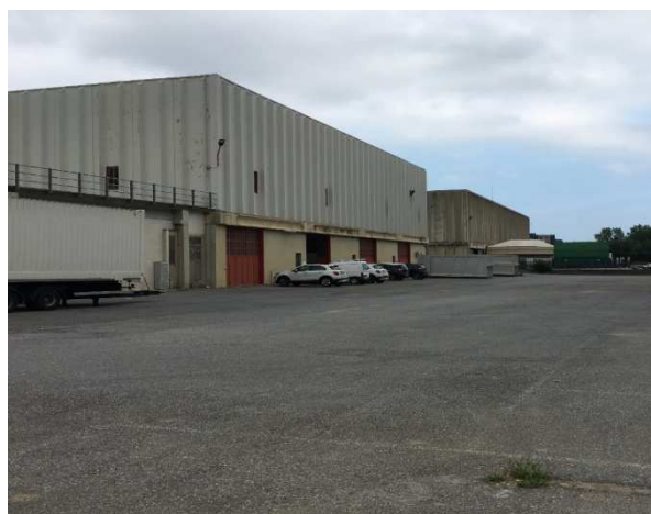
Magazzino di Cisano sul Neva (SV)
