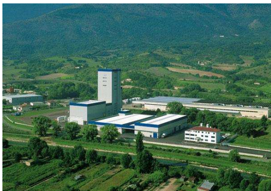
Stabilimento di Popoli (PE)
