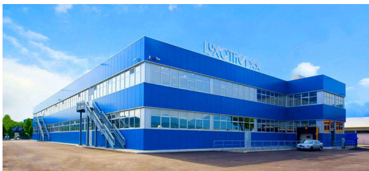
Stabilimento di Pederobba
